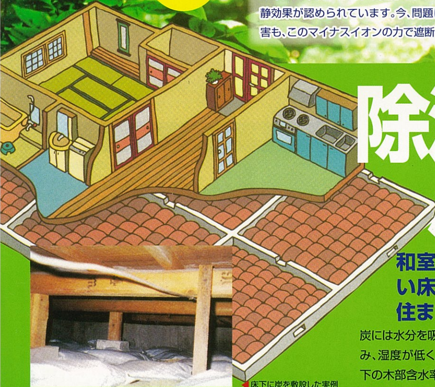
床下に炭を敷設した実例
